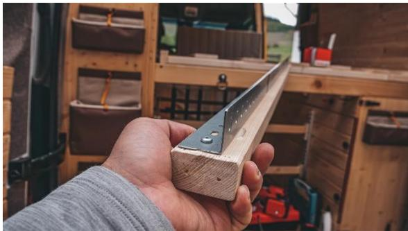
Der Winkel muss nun so ausgerichtet werden, dass die untere Winkelkante mit dem Querbalken unten bündig ist. So bleibt Platz für die Bretter, die im nächsten Schritt ausgerichtet werden. Festgeschraubt wird das Ganze dann mit 5x16 Linsenkopfschrauben.
