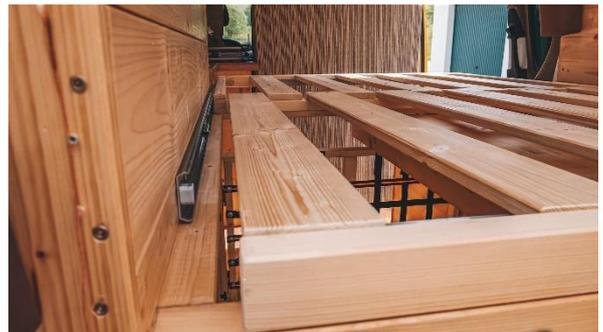
Nun werden die beiden Teile des Lattenrosts ausgerichtet und ineinandergeschoben.
