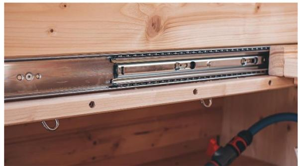
Bei Bedarf erst auflegen und Position testen, dabei 2-3 mm Luft zur Grundkonstruktion nach unten lassen.
