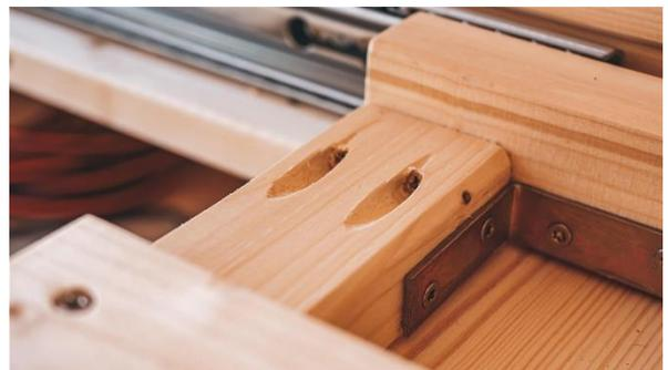
Danach wird auf die Kontaktfläche der Leim aufgetragen und mit 4,5x60 Senkkopfschrauben verschraubt.
