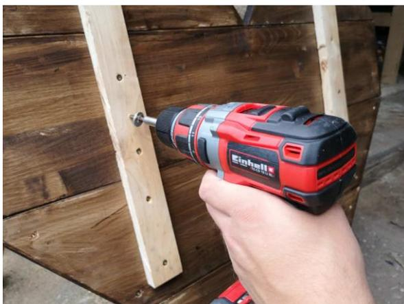
Sind die Bretter zugeschnitten, werden diese anschließend mit Schrauben befestigt. Dafür habe ich wieder ein 4 mm Loch vorgebohrt. Weil man diese Bretter nicht sehen kann, lasiere ich diese nicht mit.
