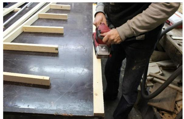
Die langen Holme kannst du dabei an einer Seite mit einer Schraubzwinde fixieren und dann nach und nach alle vier Seiten abschleifen.
