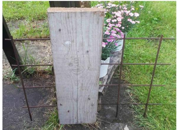
Du brauchst für das Fensterregal drei Konterlatten, die du in dieselbe Länge wie die Bohle sägst. Um diese anzubringen, misst du die Abstände der einzelnen Eisenstreben der Baustahlmatte und zeichnest sie auf den Konterlatten an.
