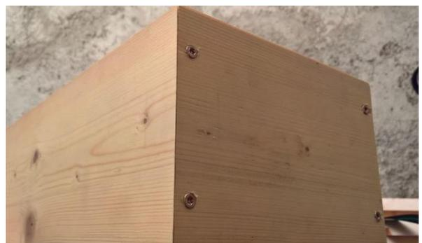
Damit die Schrauben nicht zum Blickfang werden, setzen wir sie an die schmale Seite der Einfassung und versenken ihre Köpfe, sodass sie bündig mit der Holzoberfläche abschließen.
