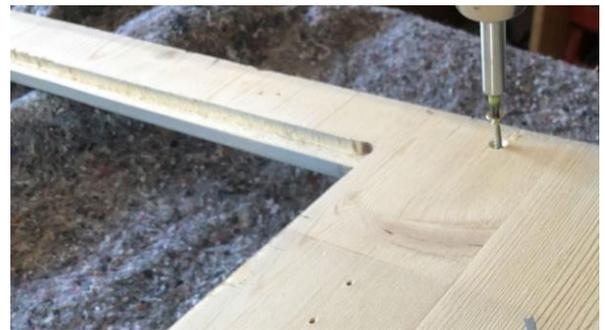
Das Gitter stecken wir nun in die zuvor gebohrten 2 mm Löcher und kleben es mit Sekundenkleber fest.
