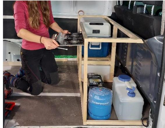
Zudem haben wir, bedingt durch die gewölbte Form der Trennwand, die Balken unter der Küchenarbeitsplatte an die Kontur der Trennwand angepasst.
