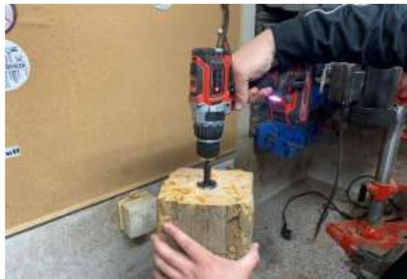
Danach setze ich einen 10 mm Bohrer einmal mittig und einmal schräg vom ausgebohrten Loch an und bohre bis der Bohrer auf der anderen Seite herauschaut.
