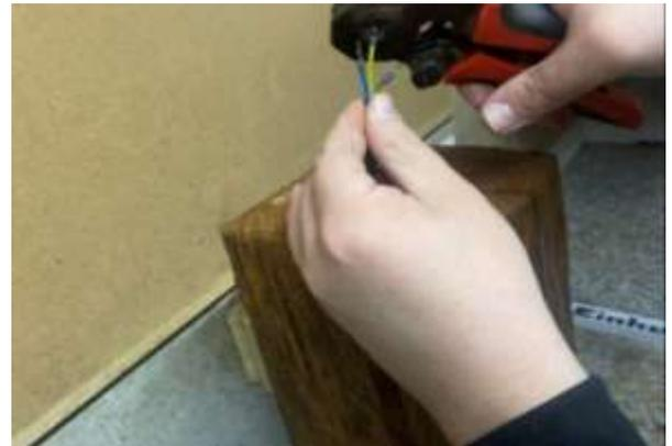
Danach schließe ich die Adern an die Fassung an. Die grün-gelbe Ader wird an den Erdanschluss in der Mitte angeschlossen (bitte drauf achten!) und die braune und blaue Ader an den anderen beiden Anschlüssen. Hierbei ist die Reihenfolge egal, da es sich um Wechselspannung handelt.
