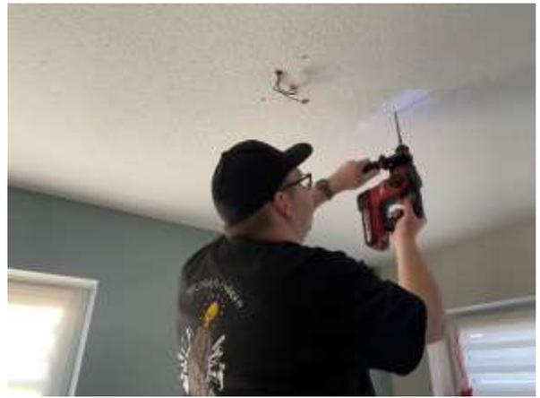
Dann klemme ich das Deckenkabel in der mittleren Verteilerdose an und schraube die Bohle mit 65 mm langen Schrauben an der Decke fest.
