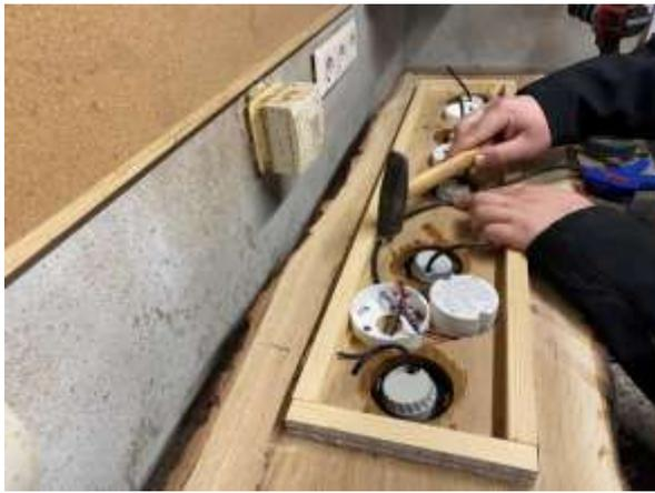
Die Zuleitung verbinde ich in der Dose jetzt mit Klemmen mit den einzelnen Strahlern. Die LED Stripes werden auch mit dem Trafo verbunden (230V auf 12V).
