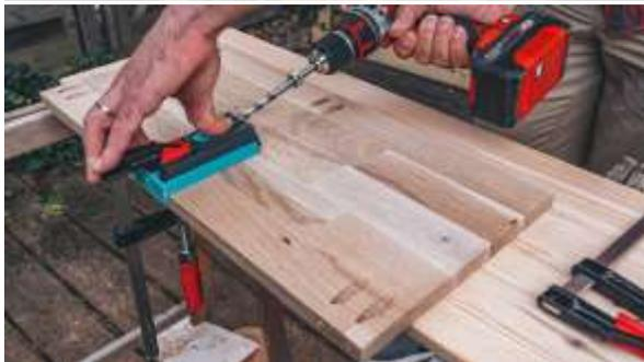
Die Bodenplatte bekommt ebenfalls Löcher entsprechend dem Bohrbild.
