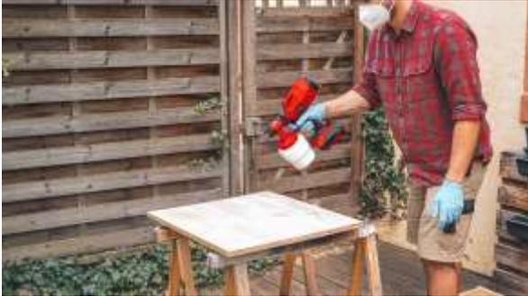
Nach der Trocknungszeit, wird nochmal zwischengeschliffen mit 240er Schleifpapier. Anschließend absaugen und eine zweite Schicht auftragen. Alternativ könnt ihr die Oberflächen auch ölen.
