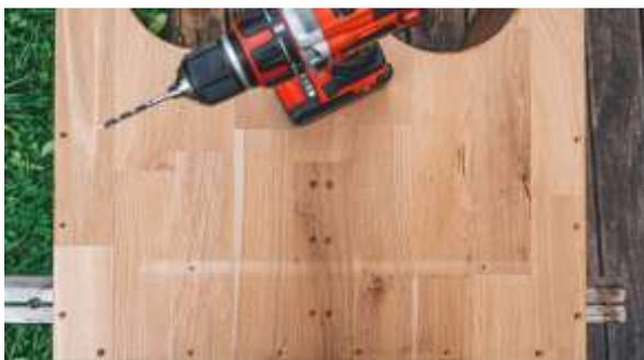
Der Futtergeber wird ebenfalls auf einer der kurzen Seiten gleichmäßig vorgebohrt und gesenkt.
