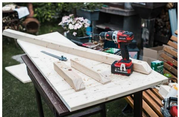
Bei der Montage solltest du darauf achten, dass die Kisten mit den Kanten des Mittelstücks abschließen. Nur an den beiden Seitenteilen stehen die Vierkanthölzer etwas über, deswegen haben sie noch eine 40 mm Phase bekommen. Dafür wurde eine Markierung bei 40 mm gesetzt und im 45 Grad Winkel mit der Kappsäge abgesägt.
