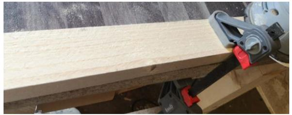
Falls du unbehandelte Fichtenholzlatten hast, solltest du diese nun abschleifen. Hierfür kannst du entweder einen Exzentrerschleifer oder Bandschleifer nehmen. Natürlich kannst du die Latten aber auch per Hand schleifen. Wir empfehlen 120er Schleifpapier zu verwenden.
