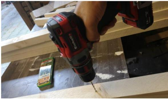
Die Stufen kannst du dann zwischen den zwei vorgebohrten Punkten ausrichten und verschrauben.
